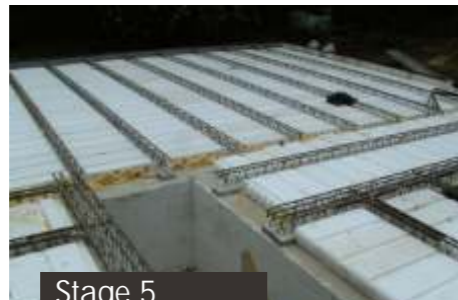
Stage 5 Floor elements ready to pour concrete
